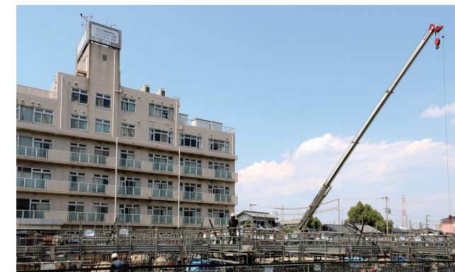
ナーシングホーム智鳥(左)の隣接地で進む、新築工事
