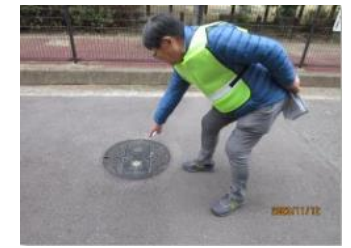
鶴見地域 避難経路の確認とマンホールチェック 地域の道路を巡回
